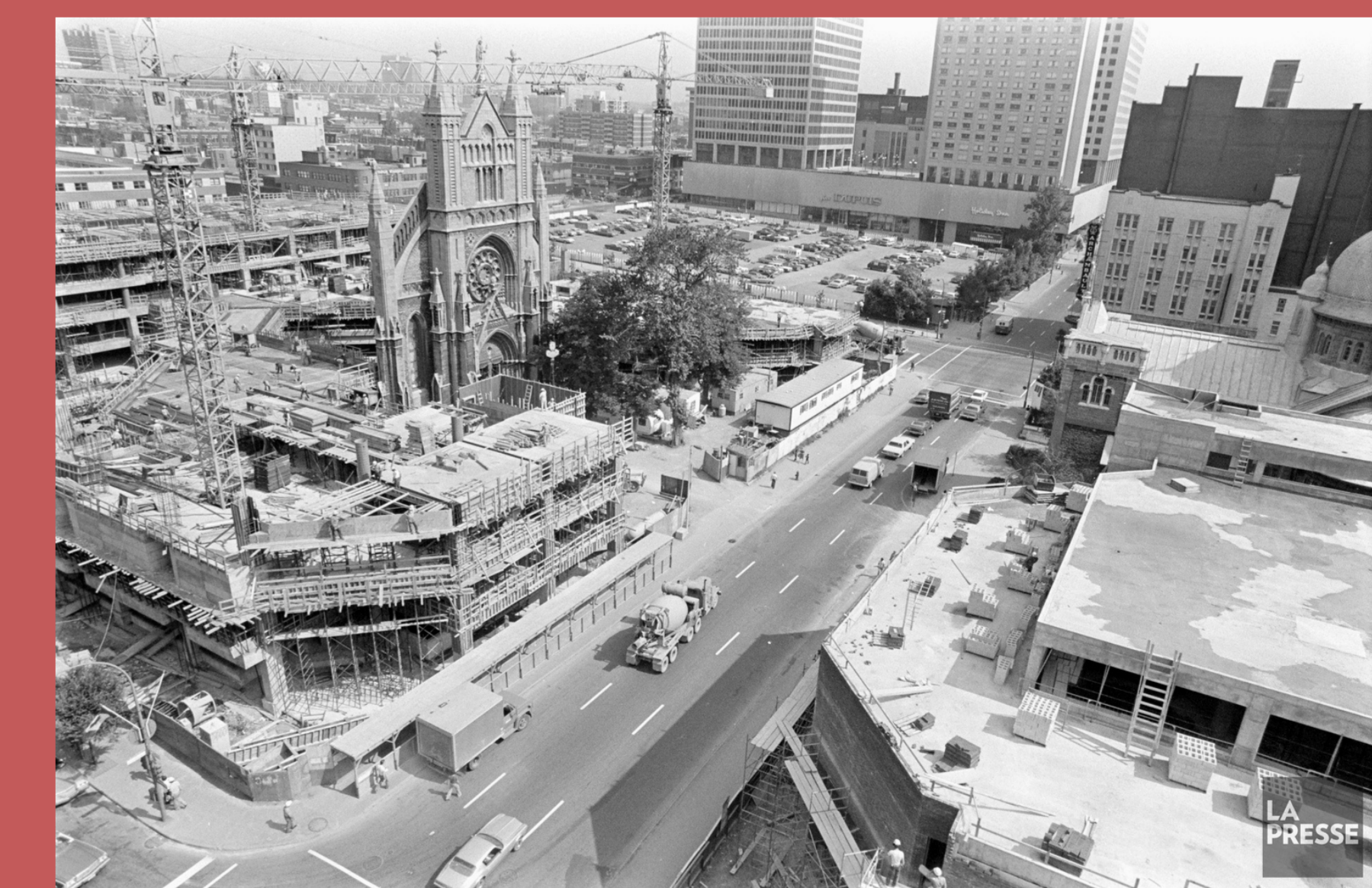
Construction de l'UQAM et le stationnement, 1977, BANQ, P83355D1977-0255_010
