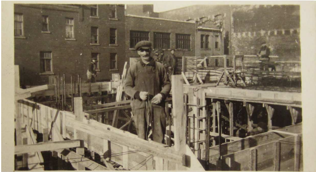
Edmond Fournier photographié au chantier de construction de la Palestre nationale à Montréal en 1914. Il était membre d'un grand syndicat nord-américain, la Fraternité unie des charpentiers-menuisiers d'Amérique, section locale 134, qui sera un syndicat de la FTQ.
